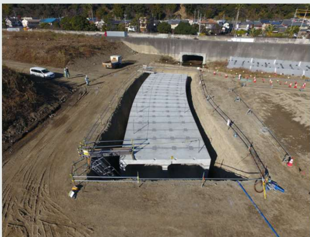
(2022年12月竣工 土木工事部) 令和4年度 清水港緑地等施設整備工事 (新興津暗渠工)
