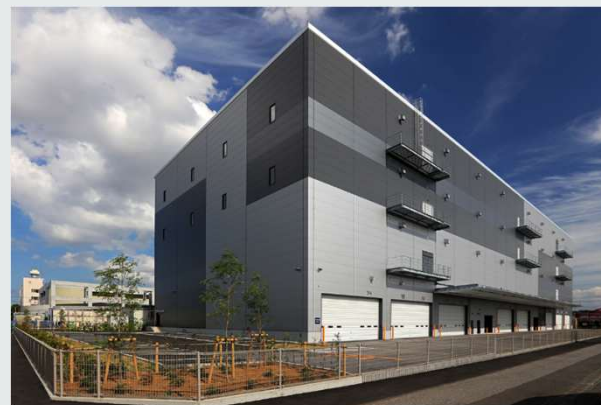
(2023年5月竣工 建築工事部) ロジスクエア松戸
