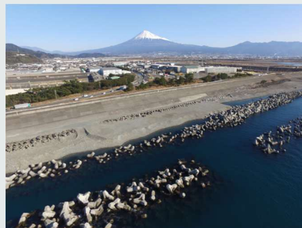
(2023年2月竣工 土木工事部) 令和4年度 富士海岸蒲原地区保全工事
